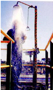
图 9-1 紧急冲淋装置
